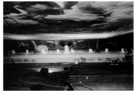
ループル美術館。ルイ16世の間、天井修復現場。
